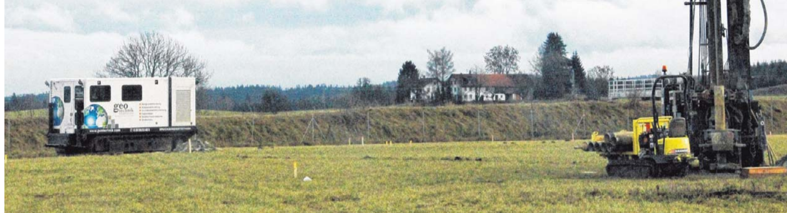
Um das künftige Allgäuer Werk der Firma Glas Marte richtig gründen zu können, werden derzeit auf dem Areal bei Kießlegg Bodenproben genommen und untersucht.
